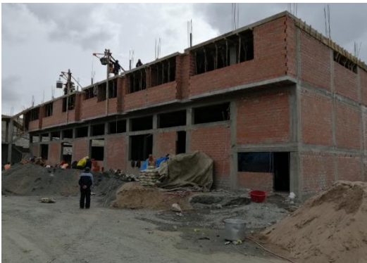
Construcción de oficinas de Cecomip
